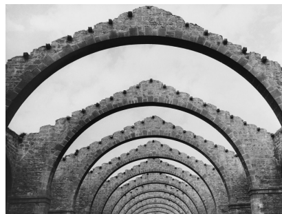
Chantier naval, Barcelone, Espagne 1959 © Lucien Hervé, Paris
