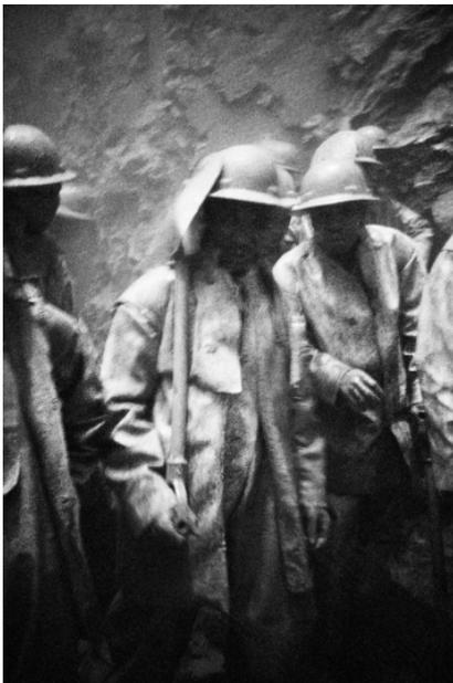
S'abritant d'un violent souffle de gravier derrière sa pelle, le bas du manche est « fauché » par un homme muni d'un tuyau d'air comprimé. Avant que le perçage des trous pour les explosifs ne puisse commencer, le fond doit être dégagé des graviers et des cailloux qui pourraient dissimuler des orifices contenant des charges non explosées provenant du cycle de dynamitage précédent. Le
